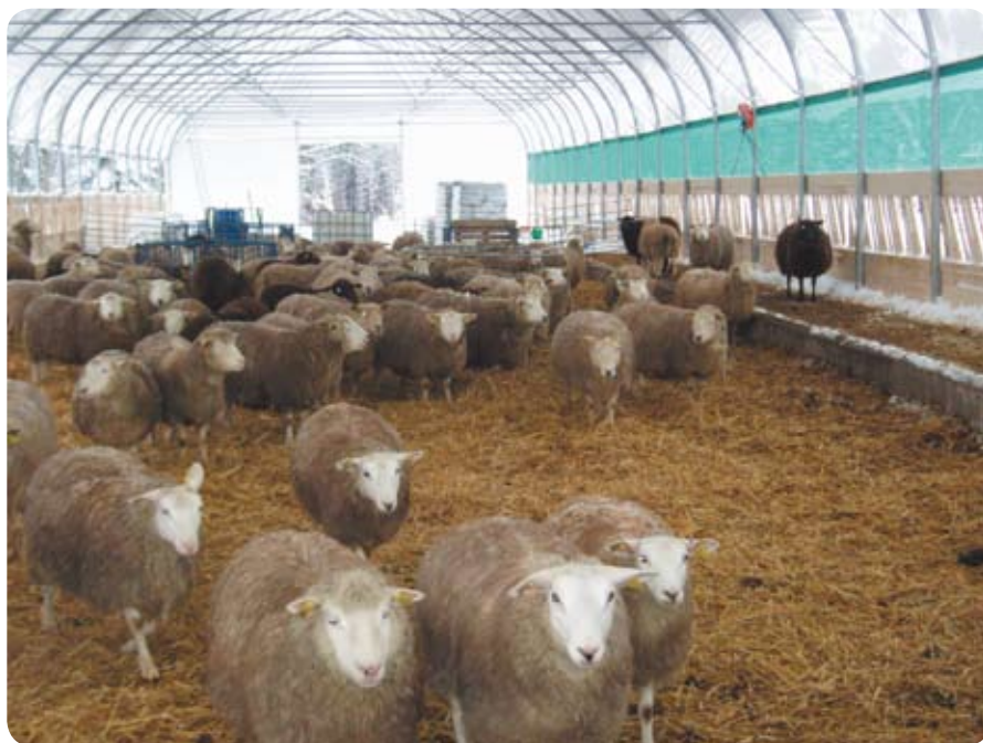
Med foderborden på utsidan utnyttjas golvytan optimalt. Djuren står på ett upphöjd del av golvet för att foderbordet ska fungera bra när ströbädden stiger.
