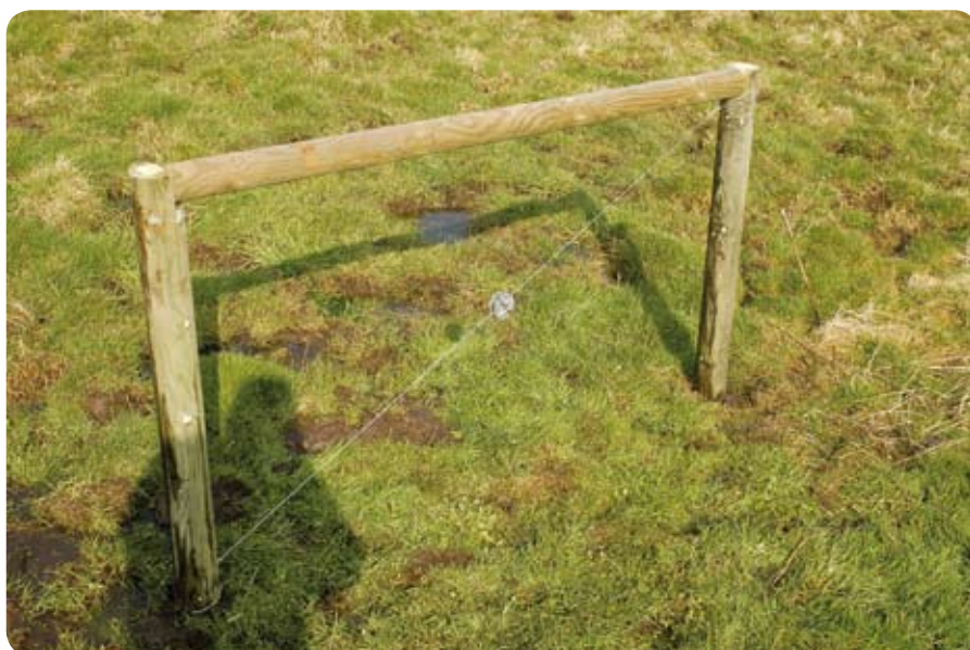
I det här fallet står parallelogrammet emot dragkraft från höger. Spänntråden ska monteras tvärtom om du har dragkraft från vänster.
